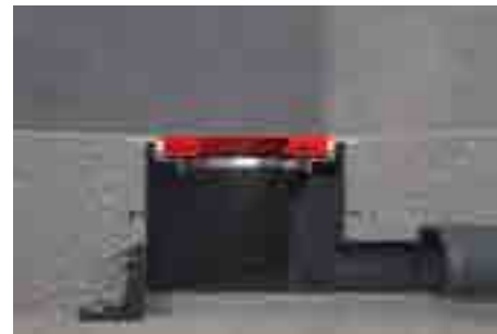
15. Verificati ca flansa de inox a sifonului sa fie acoperita de pardoseala lichida
