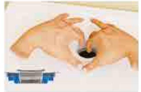
15. Apatinį „flex“ elemento žiedą užtraukite ant vožtuvo galvutės ir taip sandariai sujunkite vandens nutekėjimo vamzdį ir dušo padėklą. Įdėkite montavimo raktą ir (arba) apsauginį dangtelį į vandens išleidimo angą. Pabaigoje patikrinkite sandarumą!
