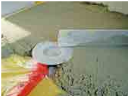
1. Izliti košuljicu u ravni sa vrhom zaštitnog poklopca
