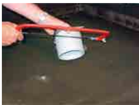
11. Skratiti nastavak na visinu pločica
