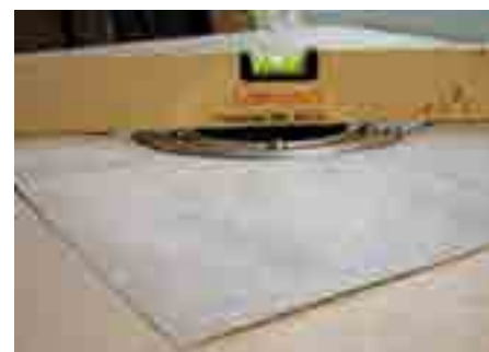
6. Hidroizolaciona garnitura je ispod nivoa košuljice
