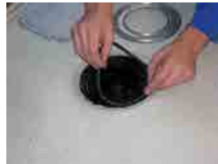
3. Zaštitni poklopac otkloniti, pribudnicu očistiti i postaviti dihtung u predviđeno udubljenje
