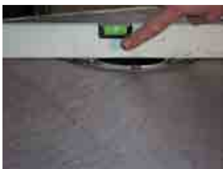
10. Kompletna hidroizolaciona garnitura je ispod nivoa košuljice što omogućava nesmetano postavljanje pločica.
