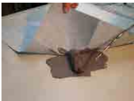
7. Hidroizolacioni premaz naneti ispod folije
