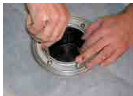
5. INOX-prsten pričvrstiti na pribudnicu slivnika pomoću vijaka
