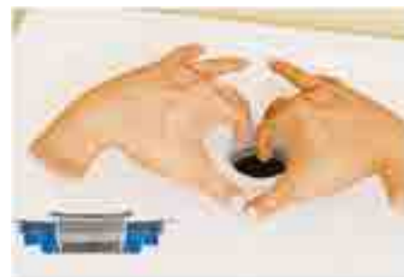
15. Vee äravooluvooliku ja dušialuse tihendamiseks tõmmake elastse elemendi alumine rõngas klapipeale. Sisestage paigaldusvõti ja / või kaitsekork äravooluavasse. Kontrollige lõpus lekkeid!
