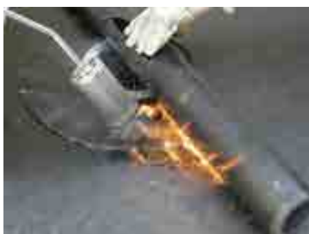
4. Ühendage teine bituumenkiht katusekaevu bituumenäärikuga
