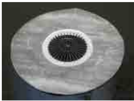
2. Paigaldage katuse älsupinnale hüdroisolatsiooni kiht.
