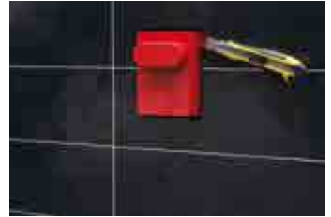
3. Lõigake korpuse osa seinapinnaga ühtlaselt
