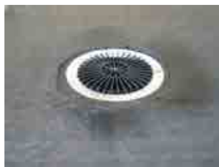
5. Katusekaevu professionaalne ühendus 2-kihilise bituumenkattega
