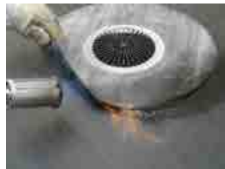
3. Keevitage bituumenäärik pinnale.
