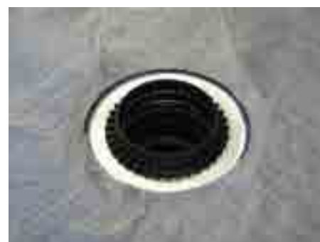
6. Eemaldage kate, paigaldage eralduskiht ja kruusakaitse HL160
