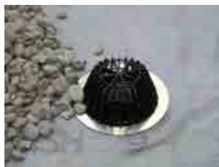
11. Paigaldage lehesõel, jaotage vähemalt 16/32 terasuurusega kruus ümber sõela
