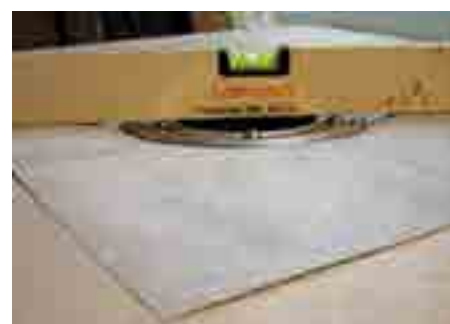
6. Tihenduskomplekt peab jääma betooni alla.
