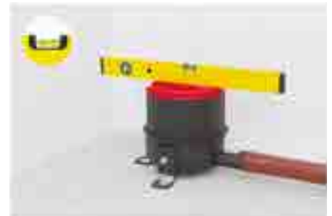
6. Ühendage äravoolu seade äravoolutoruga, reguleerige toru kaldenurka kinnitusnurkade abil.
