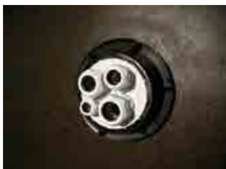
4. Sisestage valmis läbiviik HL801 torumuhvi HL800/160 ja kinnitage mutriga HL800
