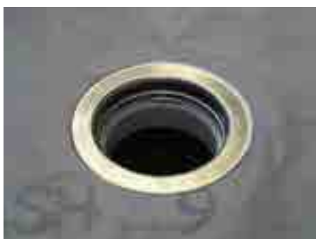
10. Kinnitage vilt kihid terasest rõngaga äärikule
