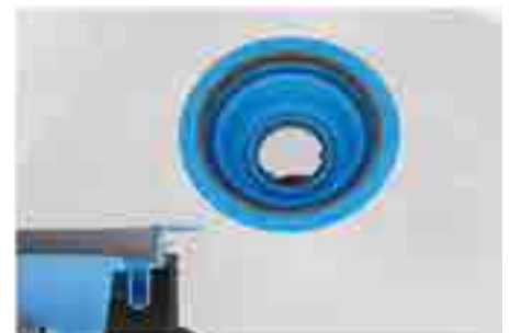
9. Sisestage integreeritud painduva elemendiga "flex" veekindluse komplekt äravoolu seadmesse, keerake kaitsekork ümber ja asetage see tagasi.
