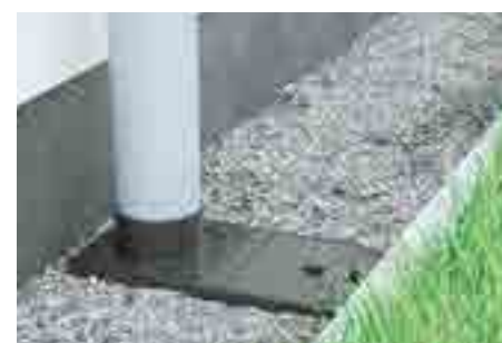
6. Ierīkojiet virsmas segumu. Traps sagatavots.
