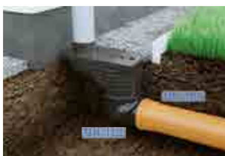
5. Pievienot notekūdeņu cauruli DN110 – tieši DN125 – nogriežot DN110 īscauruli
