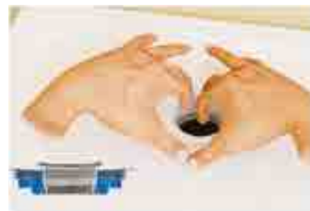
15. Apakšējo „flex” elementa gredzenu uzvelciet uz vārsta galvas, un šādi hermētiski savienojiet ūdens novadīšanas cauruli un dušas paliktņi. Ievietojiet montāžas atslēgu un (vai) aizsargvāciņu ūdens novadīšanas atverē. Beigās pārbaudiet hermētiskumu!
