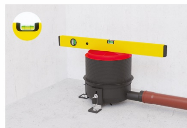
6. Ablaufkörper mit Ablaufleitung verbinden, Rohrgefälle über die Befestigungswinkel in der Höhe einstellen.
