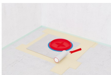
10. Feuchtigkeitabdichtung unter und ober der Dichtmanschette (Sandwichverfahren), sowie im gesamten Duschbereich auftragen. Alle Anschlussstellen mit bauseitigen Dichtbändern versehen.
