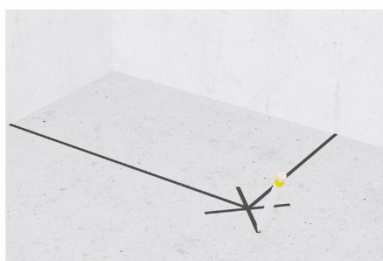
2. Mitte Ablauföffnung der Duschtasse auf die Rohdeckenkonstruktion übertragen.
