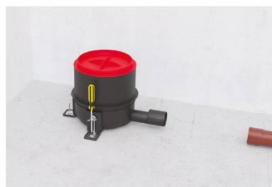
5. Ablaufkörper mittels Befestigungswinkeln an die Rohdecke fixieren.
