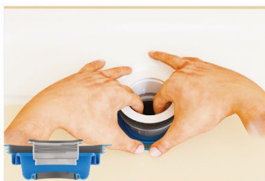
14. Den unteren Ring des Flex-Elements zum Ventilteller ziehen
