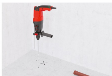
4. Löcher bohren
