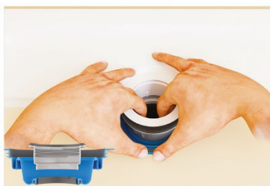
14. Den unteren Ring des Flex-Elements zum Ventilteller ziehen
