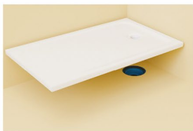
13. Duschtasse auf den Estrich versetzen
