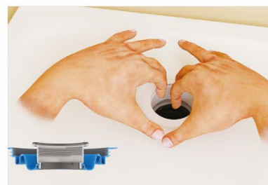
15. Den unteren Ring des Flex-Elements auf den Ventilteller aufziehen und damit Ablauf und Duschtasse dicht miteinander verbinden. Montageschlüssel/Bauschutz in die Ablauföffnung einsetzen. Anschließend: Dichtheitsprobe!
