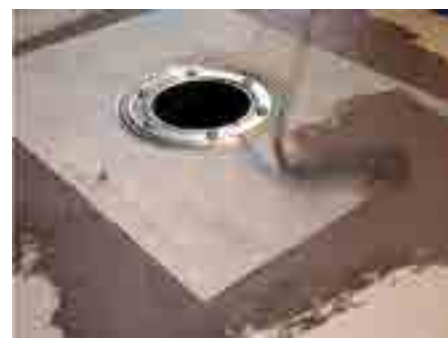
9. Izolační stěrku nanést na horní plochu izolační manžety a celého prostoru sprchy
