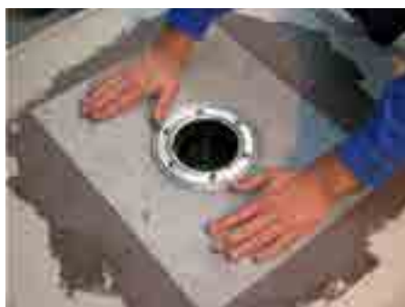
8. Izolační folii vyhladit do vlhkého podkladu
