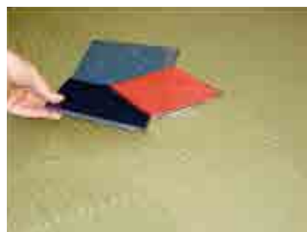
12. Vložit nástavec bez těsnícího kroužku, položit dlažbu
