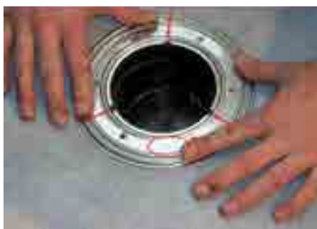
4. Centricky umístit těsnící manžetu přes izolační přírubu a nerezovou svorku, pohlídat si lícovou stranu nerezové svorky! Nápisy HL, OBEN směrem vzhůru.
