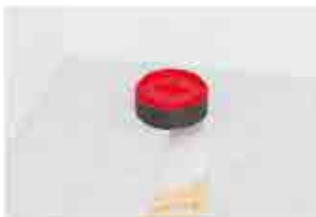
8. Po vyzrání betonové mazaniny odříznout plátem pilky vyčnívající část nástavce v úrovni betonového potěru
