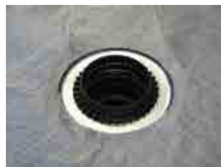
6. Ukloniti privremenu građevinsku zaštitu, postaviti zaštitni sloj i ugraditi drenažni prsten HL160
