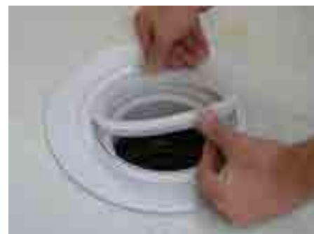
9. Postaviti bijeli plastični prsten u žlijeb koji se nalazi u pribornici slivnika
