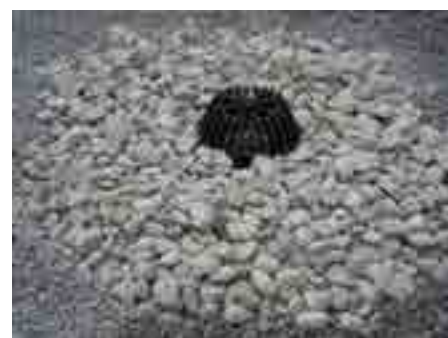
12. Ispuniti ostalu površinu sa šljunkom
