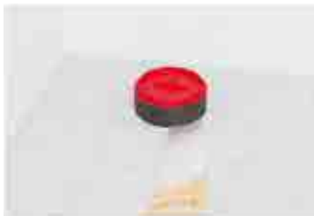
8. Nakon što se estrih stvrdne, pilom odrežite višak odvodnog tijela koji viri iznad estriha
