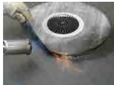
3. Navariti prvi bitumenski sloj na betonsku ploču i zavariti bitumensku kragnu slivnika sa prvi sloj
