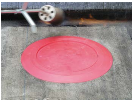
4. Zweite Bitumenlage mit Bitumenkragen des Ablaufes verbinden
