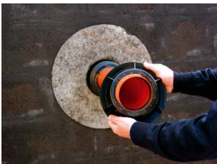
4. Sicherheitsmutter aufschrauben
