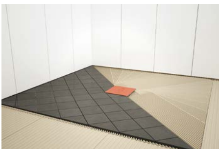
10. Aufsatzrahmen durch Drehen an das Fliesenbild anpassen (360° drehbar), Fliesen verlegen.
