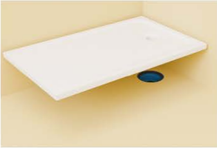
13. Duschtasse auf den Estrich versetzen
