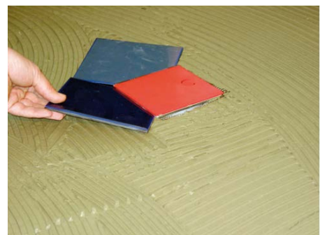
12. Aufsatz ohne Dichtung einlegen, verfliesen
