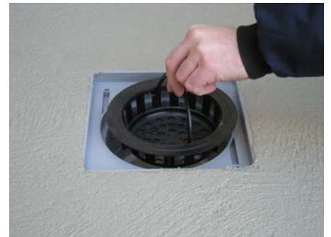
9. Einlaufrost abnehmen und Sandfang in den Ablauf einsetzen
