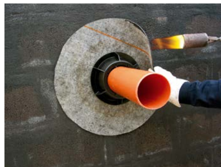
5. Bitumenbahn anflämmen
