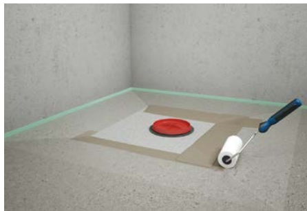
8. Feuchtigkeitsabdichtung im gesamten Duschbereich sowie unter und ober der Dichtmanschette auftragen (Sandwichverfahren), alle Anschlussstellen mit bauseitigen Dichtbändern versehen.
