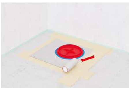
10. Feuchtigkeit abdichten unter und ober der Dichtmanschette (Sandwichverfahren), sowie im gesamten Duscbereich auftragen. Alle Anschlussstellen mit bauseitigen Dichtbändern versehen.
