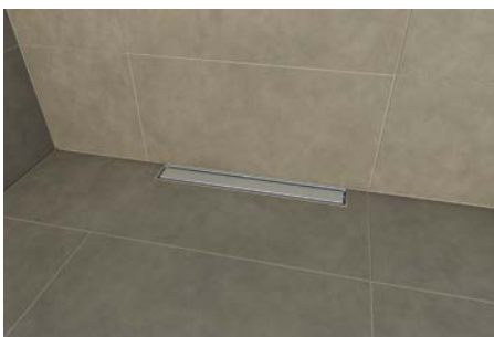
10. Bauschutz entfernen, Anschlussfugen silikonieren
