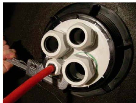
5. Leitungen/Rohre durchführen, Lagepositionierung festlegen, Klemmmuttern der Durchgangverschraubungen festziehen
