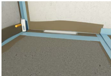
8. Dichtbänder anbringen, gesamten Duschbereich abdichten
