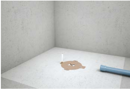
1. Ablaufposition festlegen, Montageschablone in Richtung Abflussrohr auflegen und Löcher für die Bohrungen markieren.
