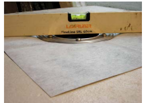
6. Die Dichtgarnitur liegt unterhalb der Estrich-Oberkante
