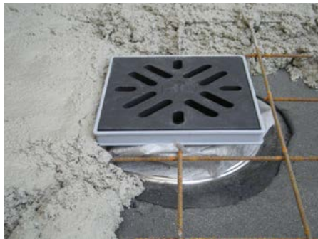
8. Mit Beton ausgießen
