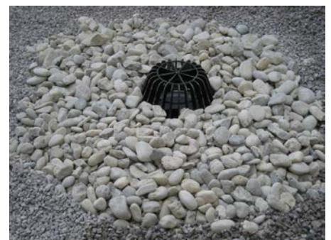
12. Restliche Fläche mit Kies ausfüllen
