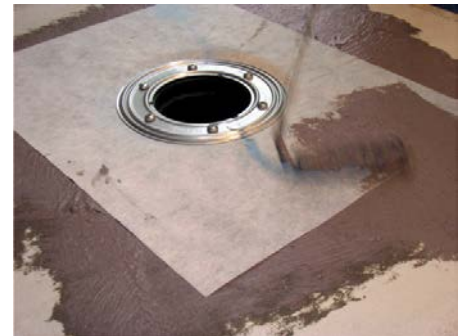
9. Verbundabdichtung vollflächig im gesamten Nassbereich auftragen
