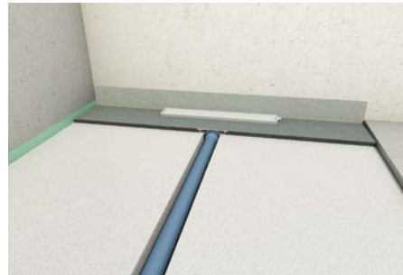
5. Trittschall- und Wärmedämmung einlegen
