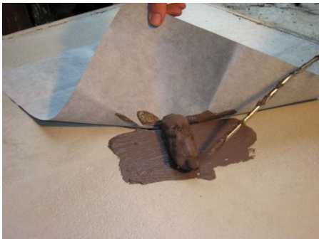
7. Verbundabdichtung vollflächig unter die Folie auftragen
