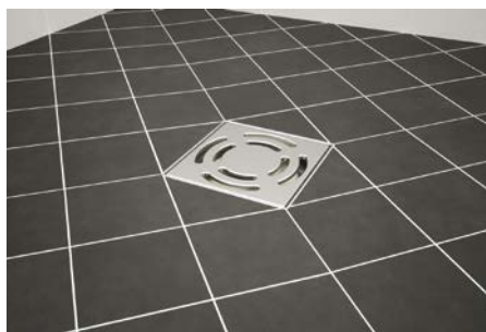
11. Bauschutz abnehmen und Edelstahlrost einsetzen.
