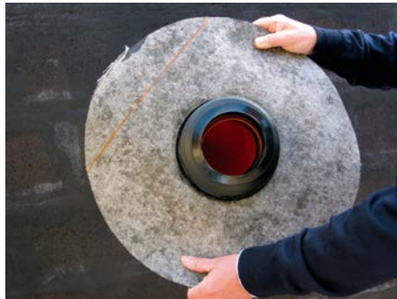
2. Bitumenkragen aufsetzen ...
