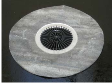
2. Voranstrich auf die Rohdecke einbringen
