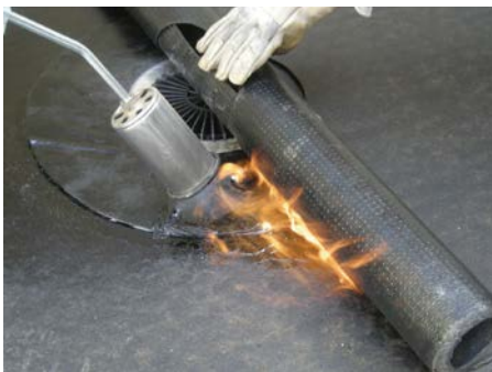
4. Zweite Bitumenlage mit Bitumenkragen des Ablaufs verbinden
