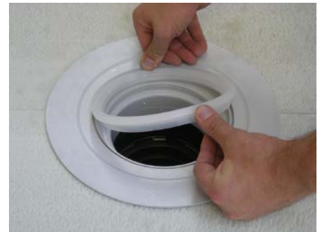
9. Transparenten Kunststofferring in die vorgesehene Ringnut des Dichtflansches einsetzen
