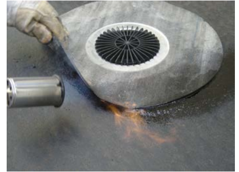
3. Erste Bitumenlage auf die Rohdecke flämmen, Bitumenkragen des Ablaufs auf die erste Bitumenlage flämmen
