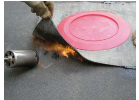
3. Bitumenkragen des Ablaufes auf die erste Bitumenlage flämmen
