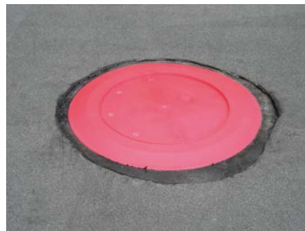
5. Fertige Einbindung des Ablaufes in die zweilagige Bitumenabdichtung
