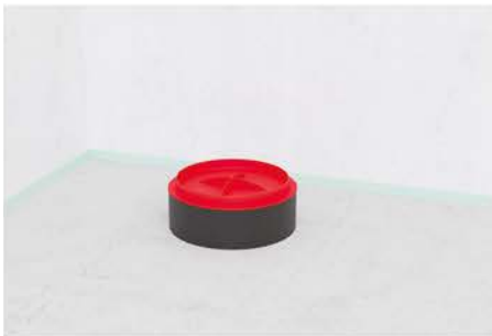
7. Fußbodenaufbau mit Estrich waagrecht herstellen.
