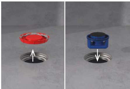
16. Bauschutz entfernen und Primusblue Geruchsverschluss einsetzen.
