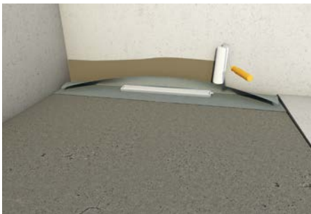
7. Werkseitig aufgebrachte Dichtfolie mit Abdichtungsmasse beidseitig einstreichen
