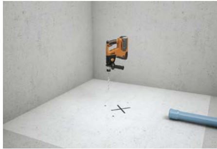
2. Löcher bohren
