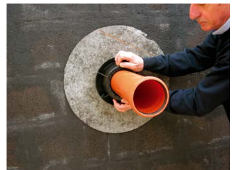
6. Sicherheitsmutter festziehen
