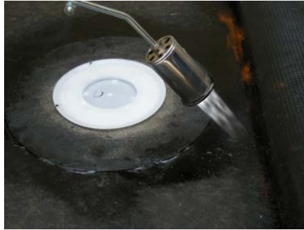
2. Werkseitigen Bitumenkragen des Abflaufs mit der bauseitigen Bitumenbahn verschweißen
