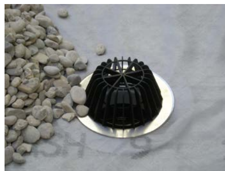
11. Laubfangkorb aufsetzen, Kiesschüttung mit Mindestkorngröße 16/32 um den Laubfangkorb verteilen
