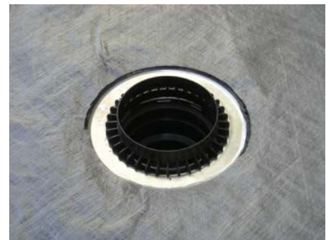
6. Bauschutz abnehmen, Trennlage auflegen, Entwässerungsring HL160 einsetzen
