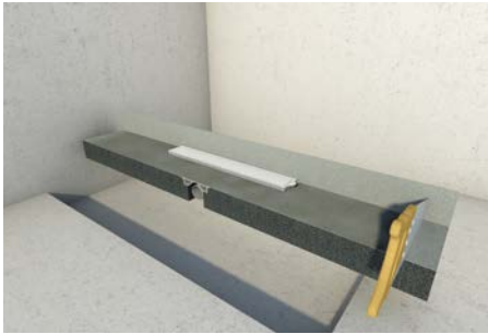
1. Duschplatz ausmessen; Duschrinne in der Länge durch beidseitiges Kürzen an den Duschplatz anpassen
