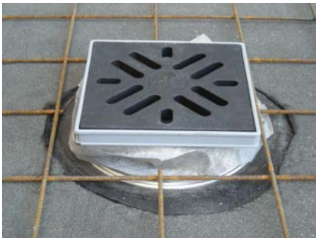
7. Aufstockelement mit Filtervlies ummanteln und Baustahlgitter auflegen
