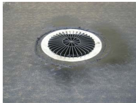
5. Fachgerechte Einbindung des Ablaufes in zweilagige Bitumenabdichtung
