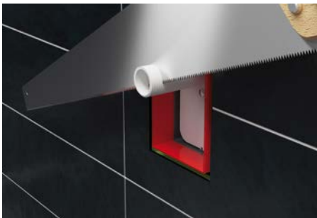
7. An der markierten Stelle ablängen.
