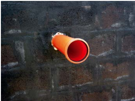
1. Rohr mit Muffenende, Wand mit Bitumenanstrich
