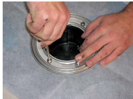
5. Edelstahlring mittels mitgelieferten Schrauben auf dem Dichtflansch anschrauben
