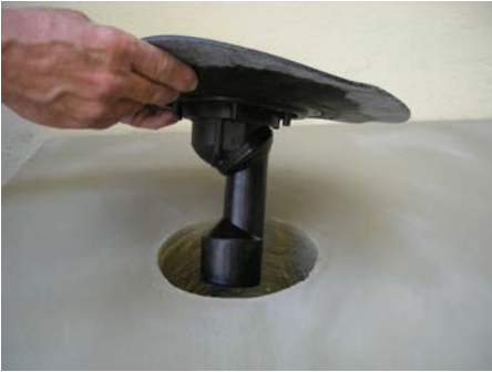
1. Ablaufkörper mit Bauschutz in den Deckendurchbruch einlegen
