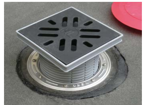
6. Bauschutz abnehmen, Aufstockelement durch Ablängen an das fertige Bodenniveau anpassen
