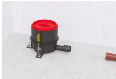
5. Ablaufkörper mittels Befestigungswinkeln an die Rohdecke fixieren.
