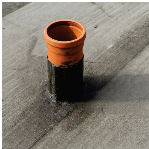
Илюстрация 3: Повдигане при преминаване на тръба
