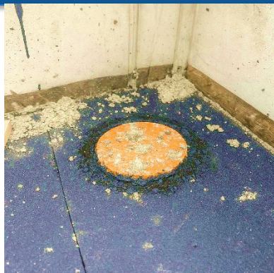
Илюстрация 2: „Хидроизолиране“ с битумен пластификатор при тръба с муфа изравнено с фундаментна плоча
