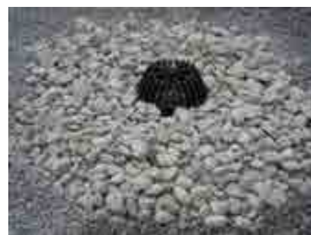
12. Засипати гравієм решту поверхні покрівлі
