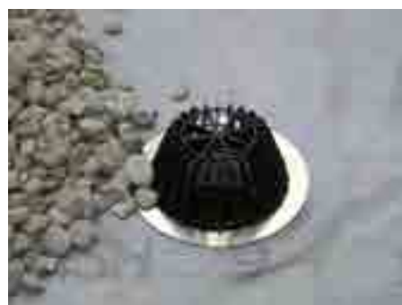
11. Встановити листовловлювач, виконати засипку гравієм (фракція: 20÷40 мм)
