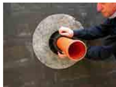
6. Затегнете допълнително осигурителния капак/гайка. Следва полагане на слоеве битумни мембрани
