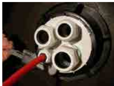
5. Прекарайте съответните тръби/кабели през подходящите щуцери, затегнете притискащите гайки на щуцерите
