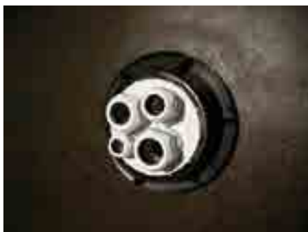
4. HL801 - редуктора с фиксираните преходни щуцери поставете в подготвения тръбен преход (HL800/160), притегнете осигурителния капак/гайка на тръбния преход HL800/160
