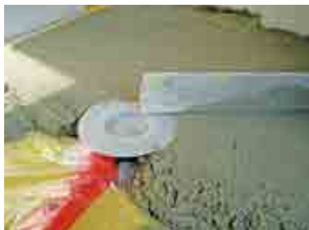
1. Полага се замазката и се изравнява по предпазния капак
