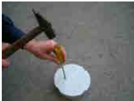
2. Избират се подходящите преходни щуцери, в зависимост от броя и диаметъра на желаните тръби/кабели и се отварят необходимите отвори
