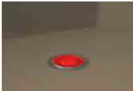
13. Tisztítsuk ki a szennyeződések a magasító gyűrűből és helyezzük be a védőfedelelet.
