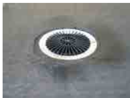
5. A szakszerűen beépített lefolyó kétrétegű bitumenlemez szigeteléssel
