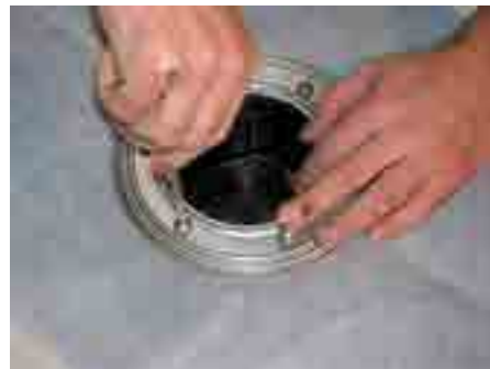
5. A nemesacél tárcsát a csavarokkal leszorítjuk
