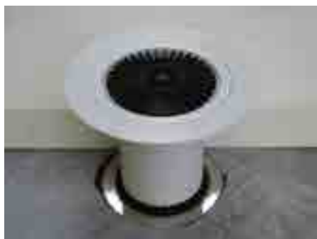
8. Elhelyezzük az átlukasztott hőszigetelő lemezt
