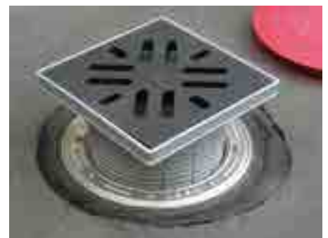
6. A védőfedelelet levesszük és a rácstartó hosszát a végleges burkolatszintnek megfelelően beállítjuk
