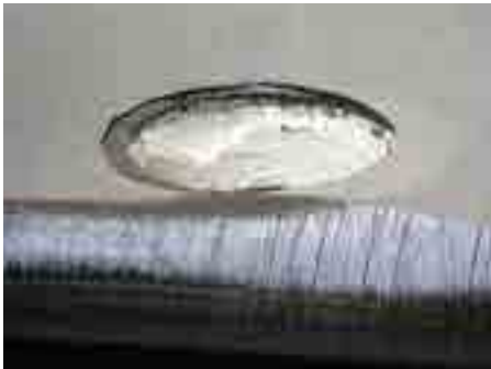
1. A magfuratot elkészítjük Ø 300 mm, bitumen kellősisítés és az első bitumenlemez réteg lefektetése
