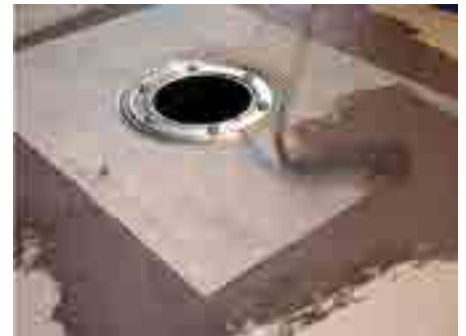
9. Majd a fólia felső oldalát, a többi szigetelendő felülettel együtt szigeteljük
