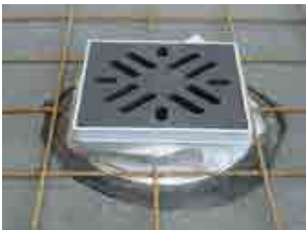
7. A rácstartó elemet geotextillel körül vesszük és a betonacél hálót lefektetünk
