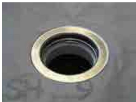
10. A szűrőfátyolt a nemesacél szorítótárcsával rögzítjük
