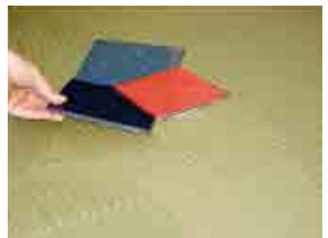
12. A magasítót tömítőgyűrű nélkül behelyezzük és csempézzünk
