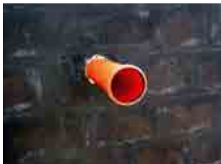
1. Cső csőtokkal, fal bitumenmázzal kellősítve
