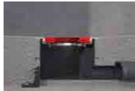
15. Ügyeljünk rá, hogy a padlóbevonat a magasító acélgyűrűt teljesen vegye körbe és szintje annak peremével kerüljön egy síkba
