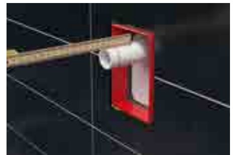
6. Jelölje a menetes hüvelyt a falsíktól 3cm-re!
