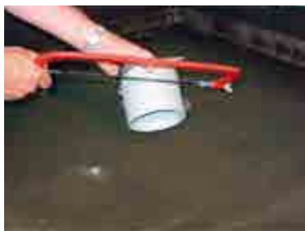
11. A rácsmagasító elemet a burkolatmagasságnak megfelelően méretre szabjuk
