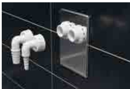
11. A menetes hüvelyek leszábása után szerelje fel az új nemesacél takarólemezt, a rozetta anyákat és a csatlakozó könyököket!
