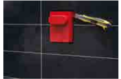
3. Beépítő-, kirekesztő ház leszábása a falsíknál.
