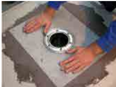
8. A fóliát rásimítjuk a kent felületre
