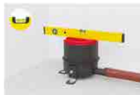
6. A lefolyótest becsövezése, csőlejtés beállítása az állítható talpakkal
