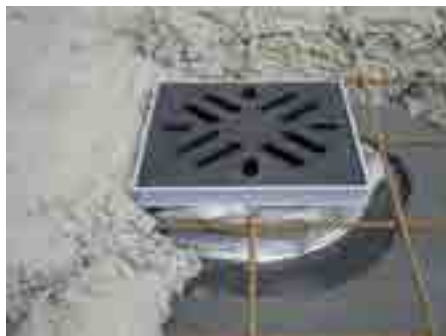
8. Betonnal feltöltjük a végleges szintig
