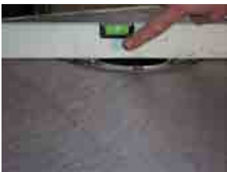
10. A problémamentes csempézés érdekében a szigetelő garnitúra a felületbe süllyesztve helyezkedik el
