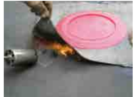
3. A bitumengallért a már lefektetett bitumenlemezhez hegesztjük
