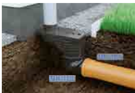
5. Ühendage vihmaveetoru DN110 otse DN125-toruga lõigates ära DN110 ühenduse
