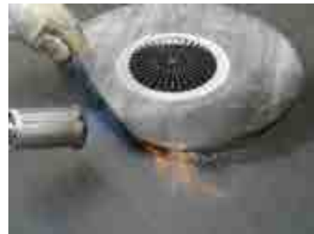
3. Keevitage bituumenäärik pinnale.
