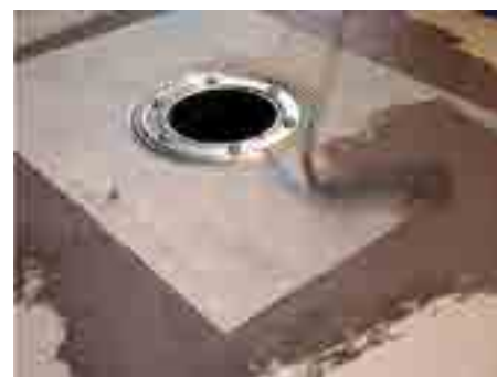
9. Kandke vedel hüdroisolatsioon kogu märjale pinnale.
