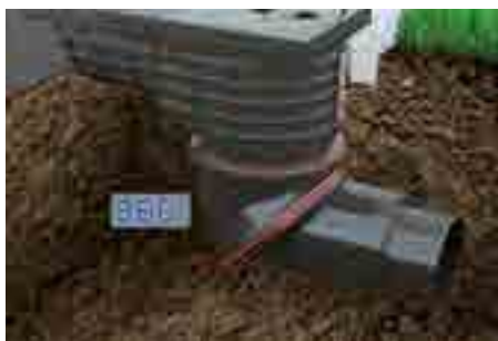
4. Kohandage kanalisatsioonitoru suunda ja nurka.
