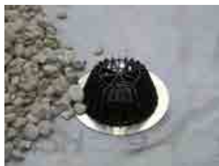
11. Paigaldage lehesõel, jaotage vähemalt 16/32 terasuurusega kruus ümber sõela
