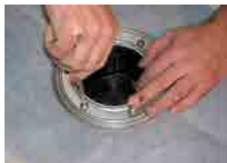
5. Kinnitage roostevabast terasest rõngas kruvidega.
