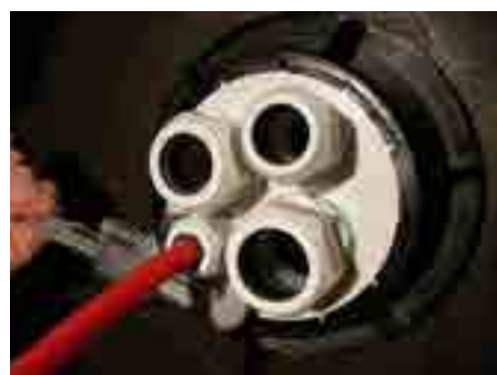
5. Tõmmake torud/kaablid läbi ja kinnitage need mutritega
