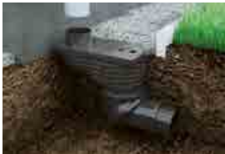
1. Paigaldage vihmatrapp.
