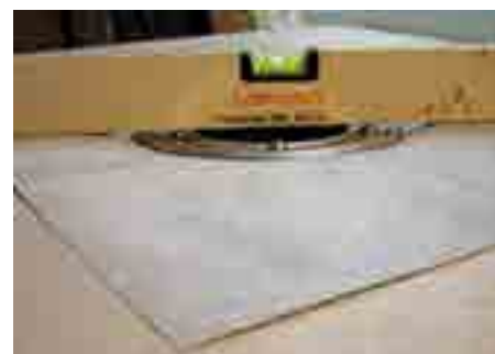
6. Tihenduskomplekt peab jääma betooni alla.
