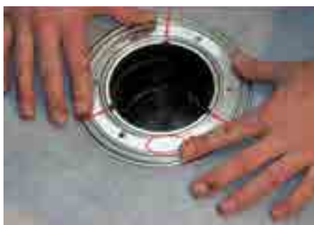
4. Paigaldage hüdroisolatsiooni membraan.
