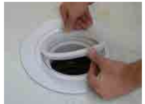
9. Užtikrinti tinkamą skaidraus plastikinio žiedo įstatymą
