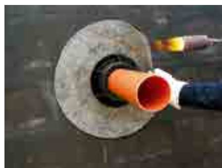
5. Prilydyti membraną prie sienos bituminės dangos.
