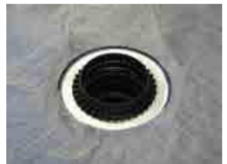
6. Ištraukti montavimo aklę, uždėti drenažinį žiedą HL160
