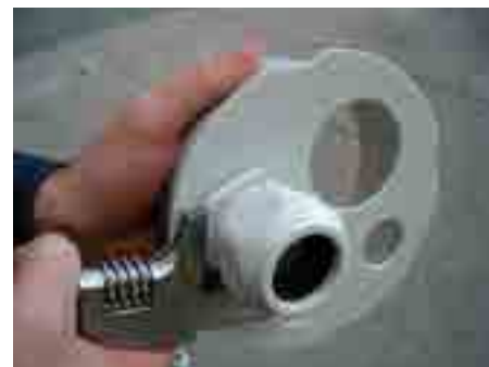
3. Įstatyti ir užfiksuoti kabelių įvadus.
