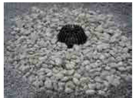
12. Užpilti žvyru likusį stogo paviršių
