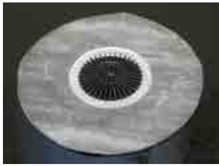
2. Užtepti grunta, priklijuoti 1-ą hidroiziacijos sluoksnį
