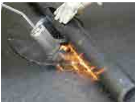
4. Priklijuoti 2-ą hidroiziacijos sluoksnį (iki apspaudimo žiedo)
