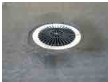
5. Taip turi atrodyti įlaja po hidroiziacijos paklojimo
