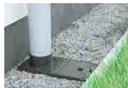
6. Instalarea este gata
