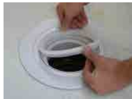
9. Убедиться в правильности установки прозрачного пластикового кольца
