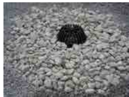
12. Засыпать гравием остальную поверхность кровли
