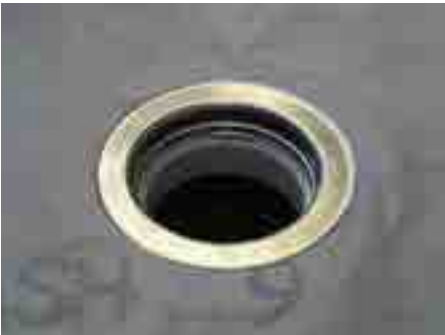
10. Filtre katmanını paslanmaz çelik halkasıyla flanşın üzerine sıkıştırın
