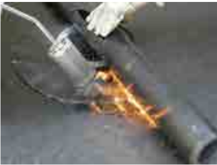
4. İkinci bitüm folyeyi süzgecin bitüm manşetiyle bağlayın
