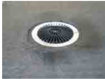
5. Çatı süzgecinin iki bitüm katmanlı su yalıtımına profesyonel şekilde uygulaması
