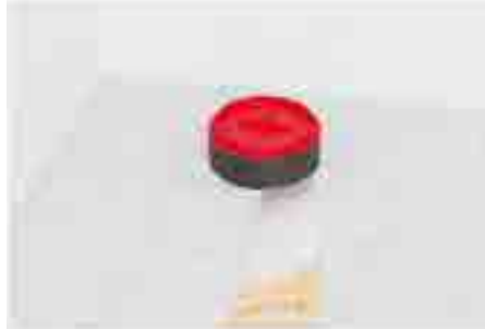
8. Şapın kurumasından sonra süzgecin üst gövdesini zemin ile düz şekilde kesin.
