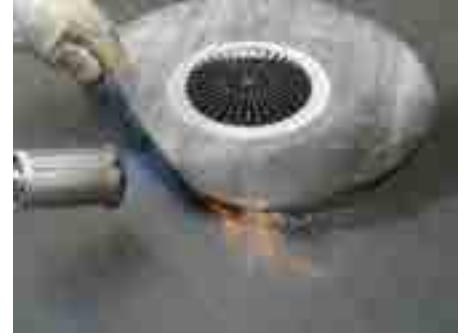
3. İlk bitüm folyeyi levha tabanına ısıtarak döşeyin, süzgecin bitüm manşetini ilk katmanın üzerine ısıtarak yapıştırın
