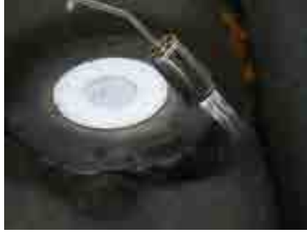
2. Süzgecin bitüm manşetini döşenen bitüm folyesi ile bağlayın
