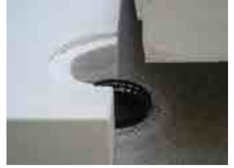
3. Ayırıcı katmanı yayın, su boşaltma halkasını (HL180) süzgecin üzerine koyun, ısı yalıtımını döşeyin
