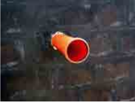
1. Muf lu boru, bitüm yalıtımlı duvar
