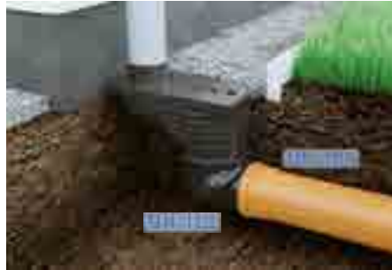
5. Kanalizasyon borusunu bağlayın DN110 - doğrudan DN125 - kesin!
