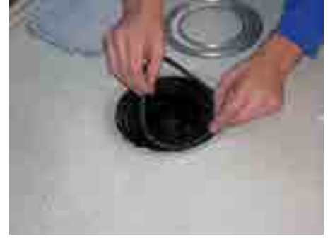
3. Flanşı temizleyin ve contayı flanşın boşluğuna yerleştirin
