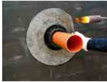
5. Bitümü ısıtarak yapıştırın
