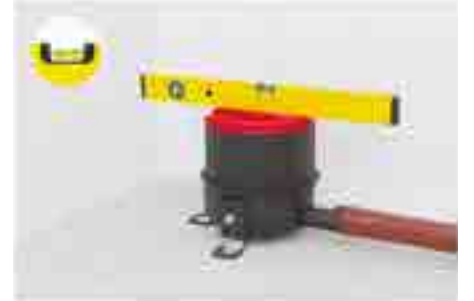
6. Atık su borunun eğimini süzgecin yüksekliğini belirleyerek ayarlayın ve sabitleme parçalarını sıkın.
