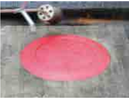
4. İkinci bitüm membranı süzgecin bitüm manşeti ile birleştirin
