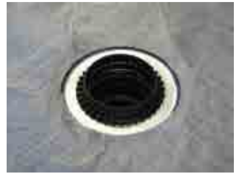
6. Yapı korumasını indirin, ayırıcı katmanı döşeyin, HL160 su boşaltma halkasını yerleştirin
