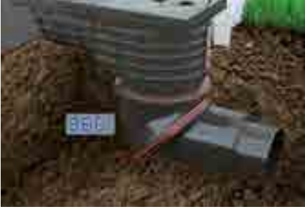
4. Çıkış borunun yönünü ve eğimini ayarlayın
