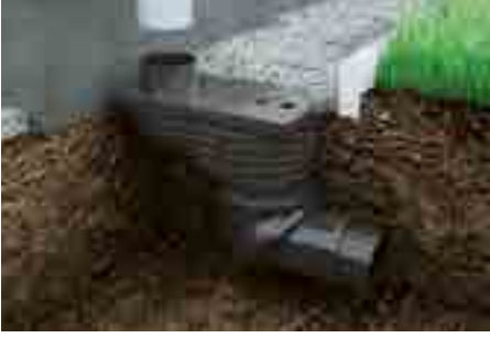
1. Yağmur suyu kutusunu yerleştirin
