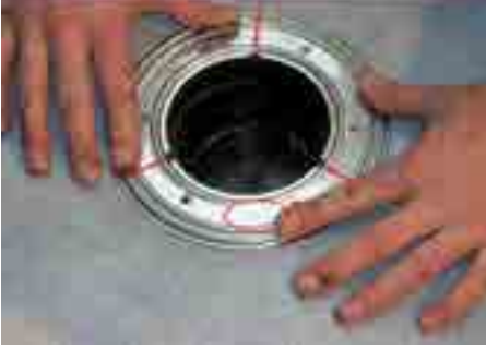
4. Folyeyi döşeyin ve paslanmaz çelik yüzüğünü üstüne yerleştirin, üst (OBEN) yazısının üste olmasına dikkat edin!
