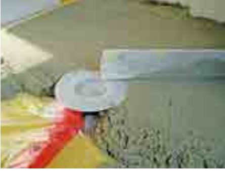
1. Şapı döküp, yapı korumasının üzerinden eğimli düzleyin
