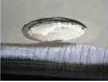
1. Ø 300 mm ölçüde deliği açın, astar katmanı sürün, birinci bitüm membranı döşeyin
