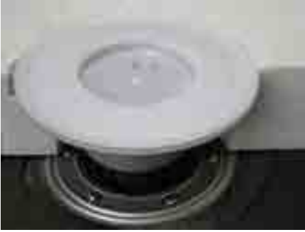
4. Flanşlı yükseltme parçasını (HL85N) kısaltın ve ısı yalıtımın seviyesine getirin, su boşaltma halkasının (HL180) üzerine koyun, yapı korumasını takın
