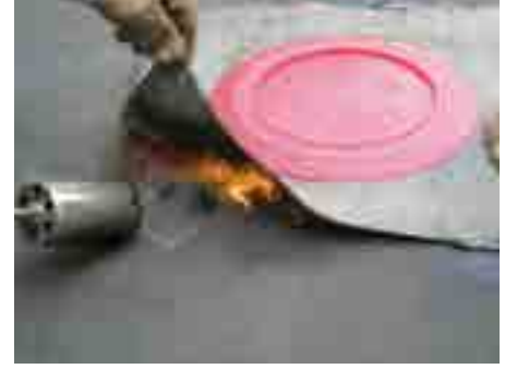
3. Süzgecin bitüm manşetini birinci bitüm membranın üzerine ısıtma işlemiyle kaynatın
