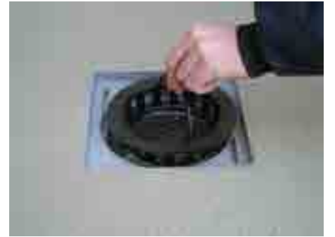
9. Izgarayı indirin ve kum tutucuyu süzgecin içine yerleştirin
