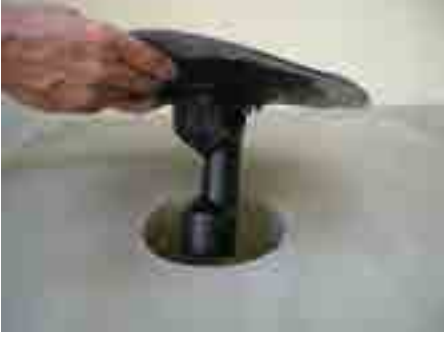
1. Süzgeç gövdesini yapı koruması ile tavanın boşluğuna yerleştirin
