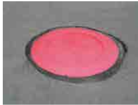
5. Süzgecin iki katlı bitüm membranı ile birleşmiş, hazır durumu
