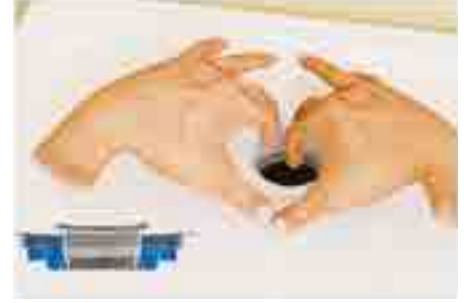
15. Halkayı kontra somuna oturturduktan sonra, kırmızı yapı korumasını takın, drenaj ve sızdırmazlık probası yapın.
