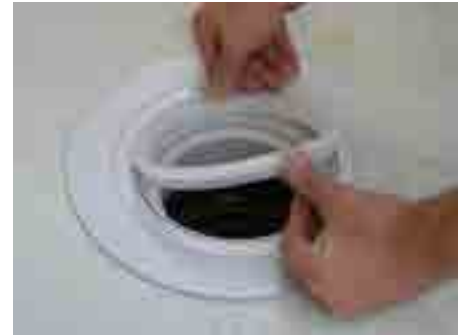
9. Şeffaf plastik contayı flanşın üzerine yerleştirin
