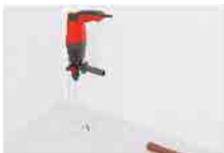
4. Просвердлити отвори під кріплення
