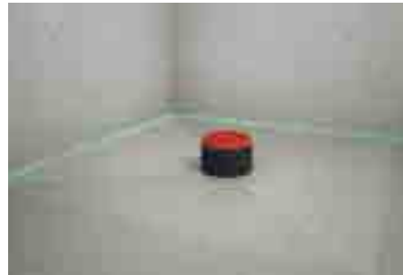
5. Estrich einbringen und im Duschbereich mit einem Mindestgefälle von 2% ausbilden.
