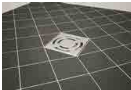
11. Bauschutz abnehmen und Edelstahlrost einsetzen.
