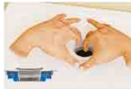
15. Свържете плътно сифона и душ-коритото. Използвайте монтажния ключ за допълнително притягане. След това: направете водна проба за течове!
