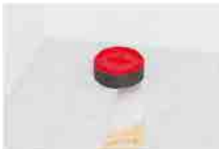
8. Nakon što se estrih stvrdne, pilom odrežite višak odvodnog tijela koji viri iznad estriha
